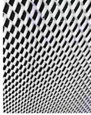
Sträckmetall med olika grader av transparens/genomsläpplighet
